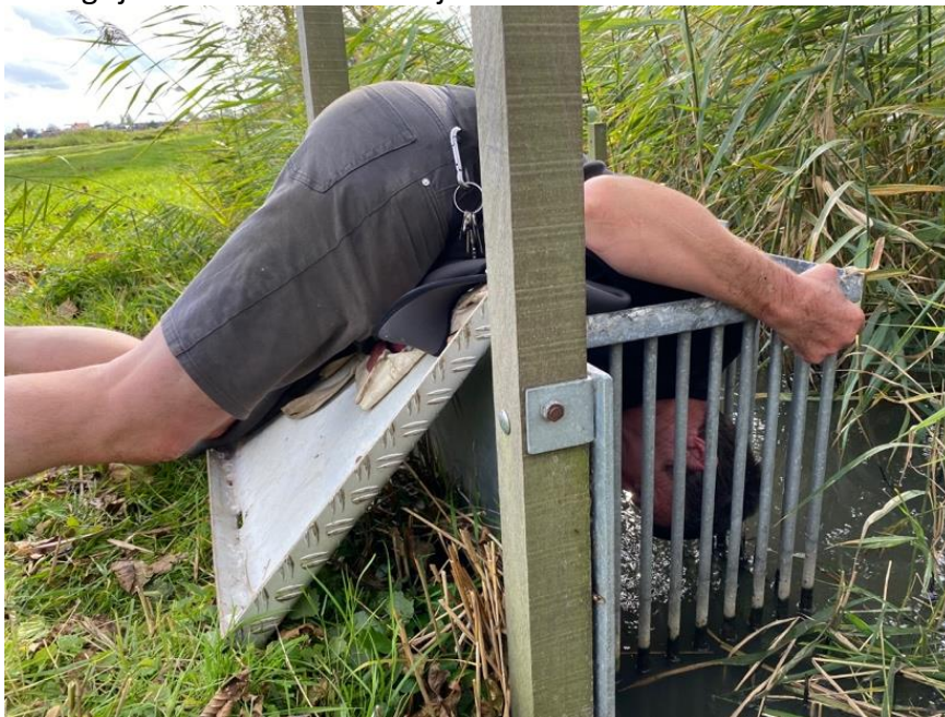
Paul van Trigt bevestigt de door hem gemaakte klepduiker onder water. Hiermee kunnen we beter de waterstand in het Landje van Gruijters regelen / Johan Stuart
